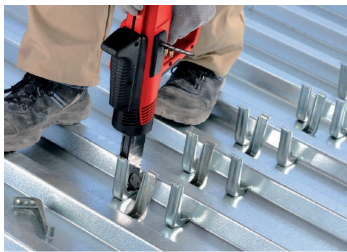
Conectores fijados mecánicamente
