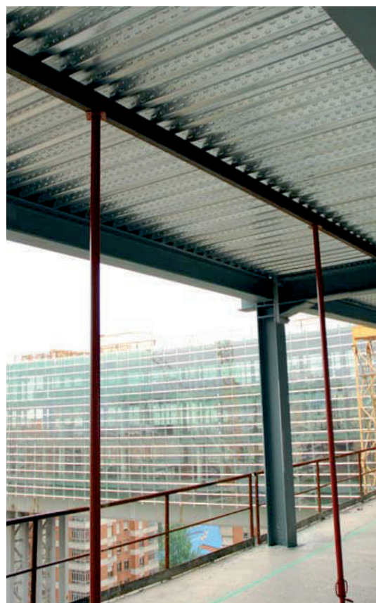
Imagen apuntalamiento provisional
